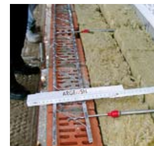
Prüfung der Ausführungsqualität von Bauleistungen
