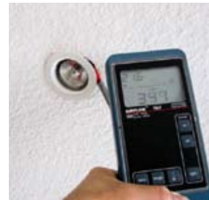
Prüfung auf mögliche Fehlstellen
